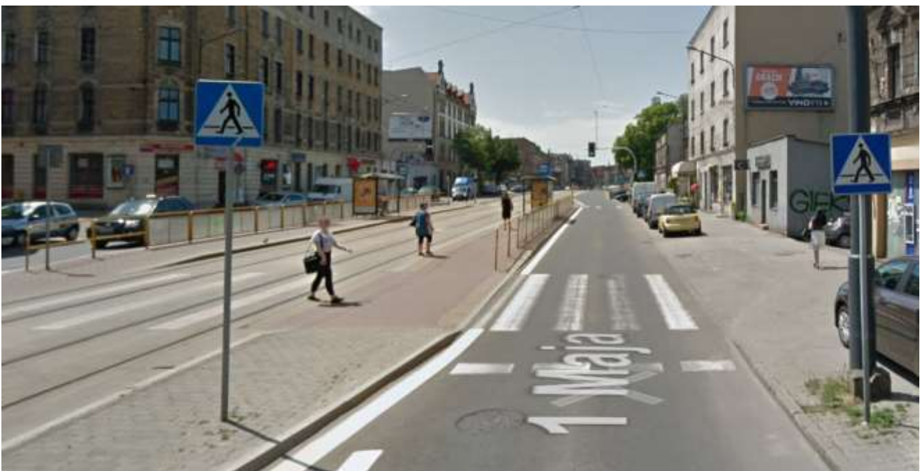
Rysunek 19 Przystanek tramwajowy w Katowicach – Zawodzie Paderewskiego z podwójnym przejściem dla pieszych.
