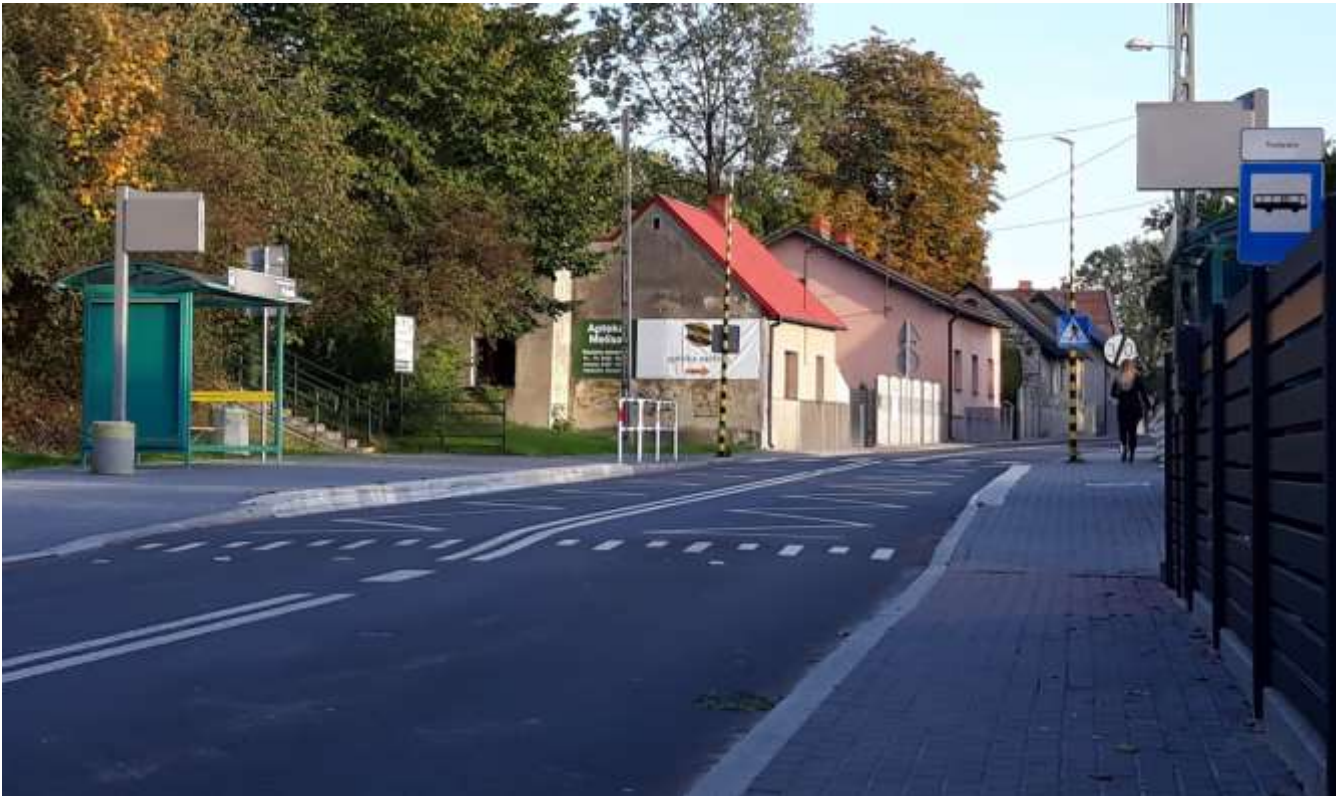
Rysunek 13 Przykładowy przystanek na wzór przystanku wiedeńskiego (Jaworzno Podwale) Źródło: opracowanie własne
