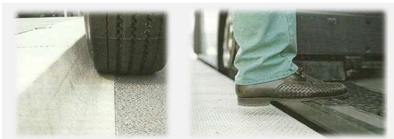
Rysunek 31 Profilowane krawężniki peronowe na przystanku
