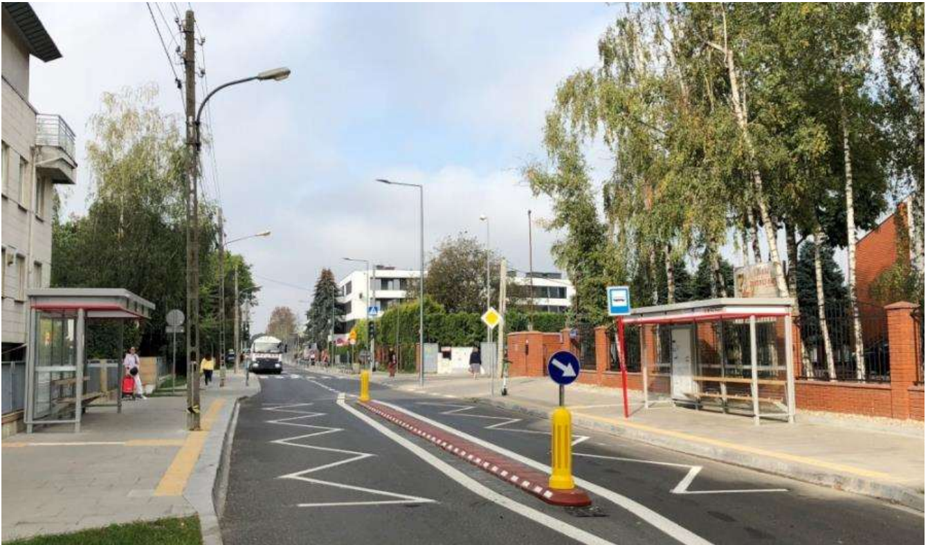
Rysunek 7 Zastosowane separatory na przystanku przy ul. Włodarzewskiej w Warszawie
